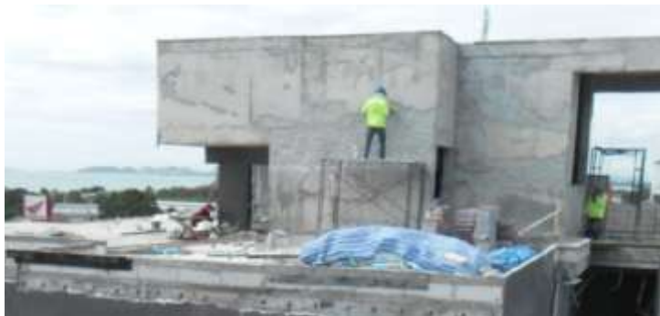
ภาพที่ 3 การยึดแบบสำหรับหล่อคอนกรีตไม่แน่นพอทำให้เกิดปัญหาความสูญเสียวัสดุและแรงงาน
