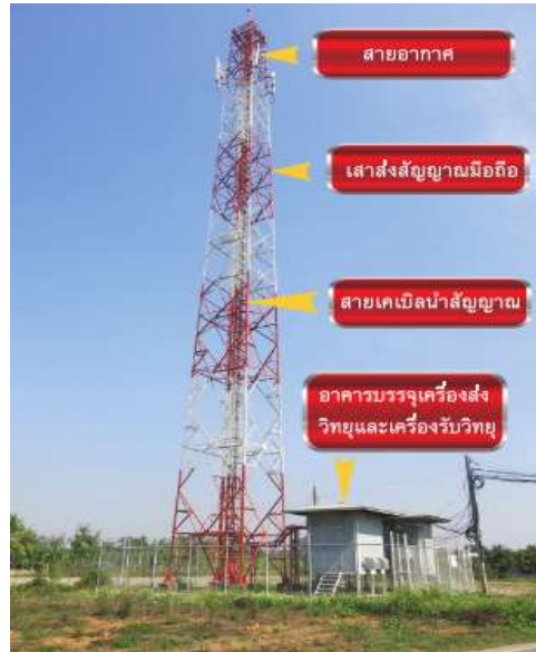
ภาพประกอบ 1) สถานีฐานของระบบโทรศัพท์มือถือแบบโครงสร้างเหล็ก ที่มา: สำนักงานคณะกรรมการกิจการกระจายเสียง กิจการโทรทัศน์ และกิจการโทรคมนาคมแห่งชาติ หรือ กสทช.
