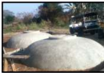
รูปที่ 8 บ่อก๊าซชีวภาพแบบโดมคงที่ (Fixed dome) ที่มา : เฉลยทรัพย์ฟาร์ม
